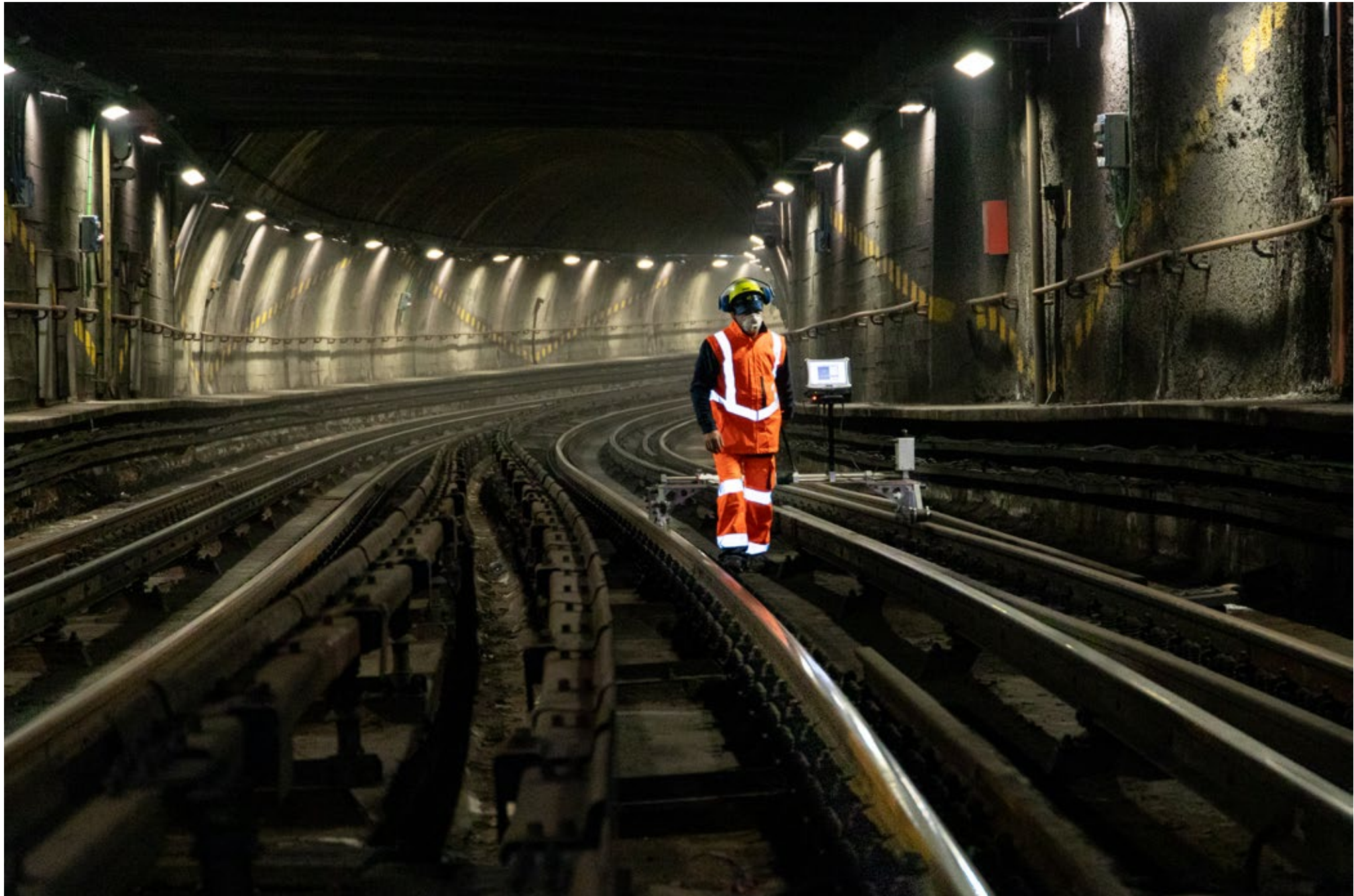
Tecnico in ricognizione notturna nelle gallerie della metropolitana. Technician on a night inspection in the tunnels of the metro.
